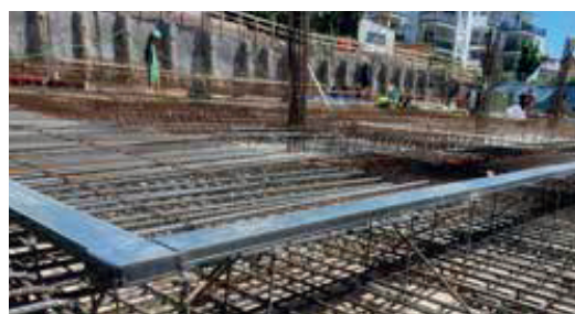
Montage AquaStop mit Rinnenaufständering
