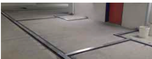
Montage AquaStop mit Rinnenaufständering
